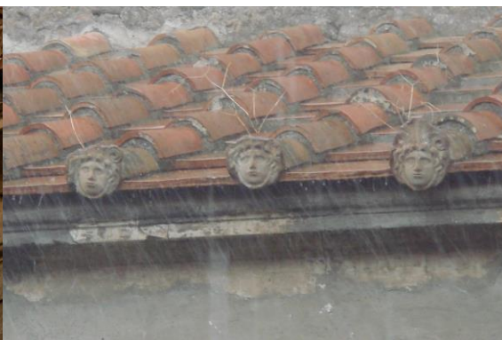
Foto 27 Compluvium en funcionamiento, Villa los misterios, Pompeya. Fuente: M. Fraile
