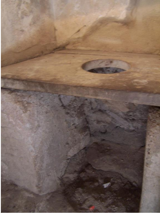
Foto 138: letrina en el Lupanar de Pompeya. Fuente: M. Fraile
