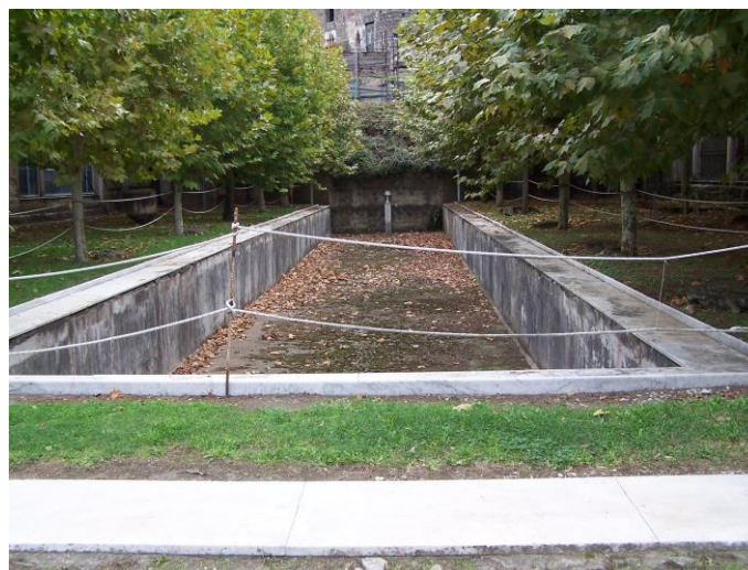
Foto 86: Natatio Villa Ariadna. Stabia. Fuente: M: Fraile
