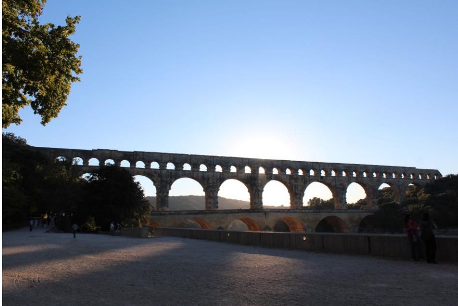
Foto 42: Pont de Gar. Francia. Fuente M Fraile
